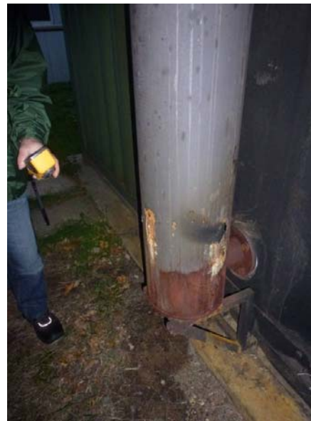
Abb. 11: durchgerosteter Abgaskamin
