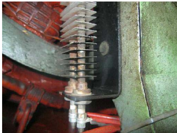
Abb. 8: Korrosion und Salzablagerungen
