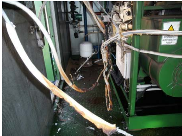
Abb. 14: Brandschaden im BHKW - Container
