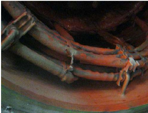
Abb. 7: Ablagerungen und Korrosion im Geno
