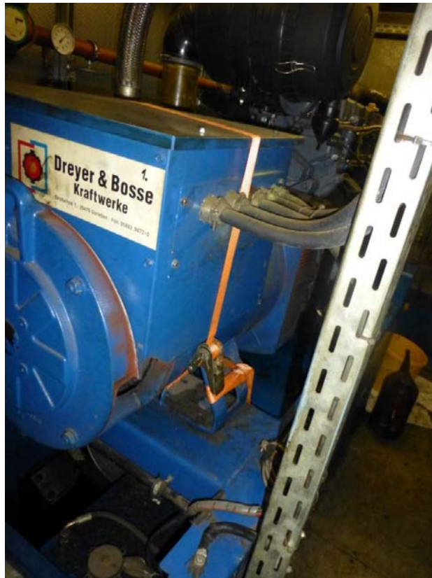
Abb. 10: Generatorbefestigung
